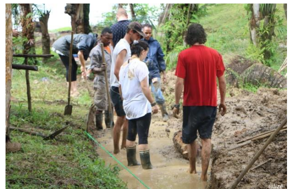
Travaux de canalisation sur le site
