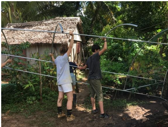
Installation d'une mini serre chez l'habitant
