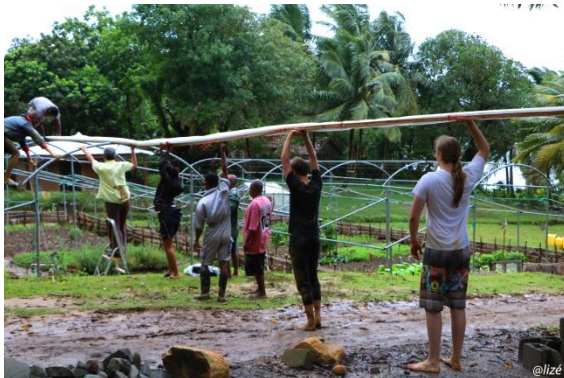
Restauration des baches des grandes serres
